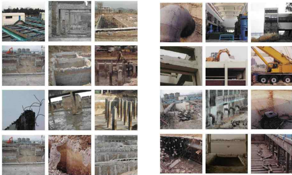
[그림 2] 정수장 Renovation 과정
