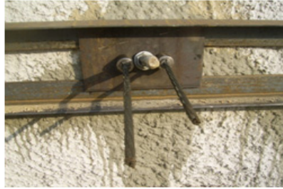
(e) L형 bar 및 지압판 설치
