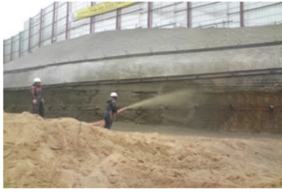
(a) 슛크리트 타설
