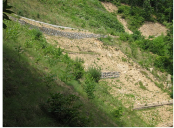
(b) 임도 하부 사면파괴 전경 그림 5 토석류 발생부 구역 모습
