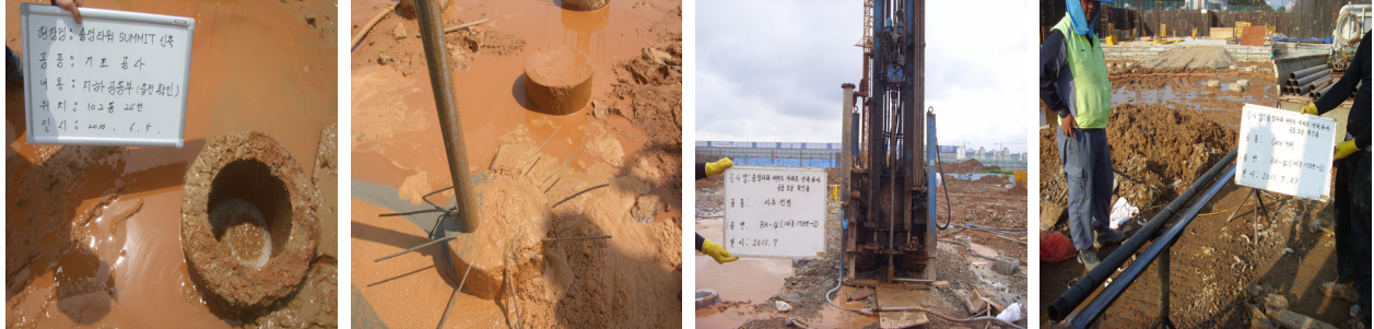
그림 13. 그라우트 충전확인 및 확인용 코어채취
