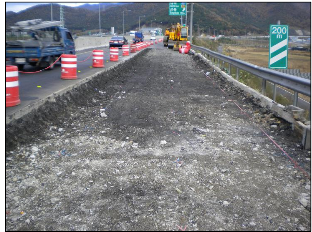
b) 침하구간 기존 도로 깨기 완료 후 전경
