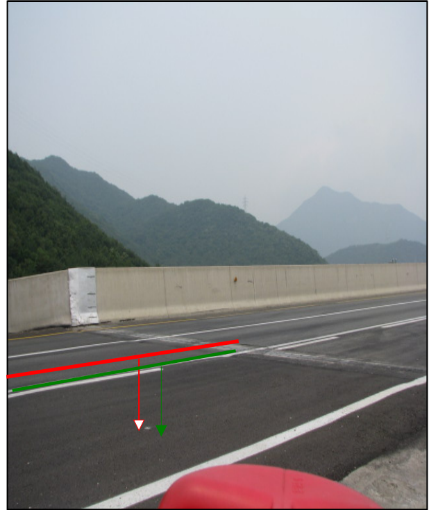
그림 4. 포장 덧씌우기시공 후 침하발생
