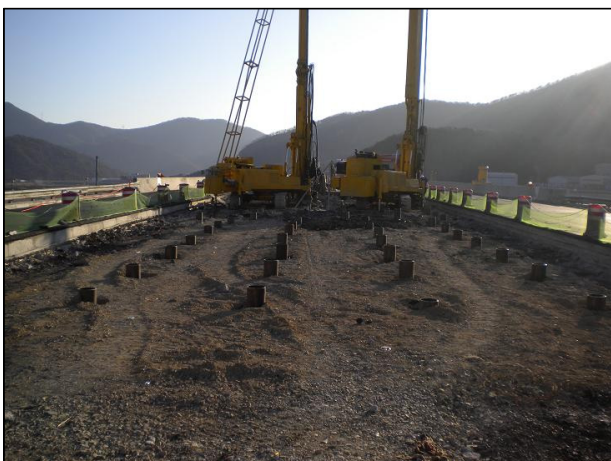
e) 연약지반 Twin-Jet 보강공법 시공전경
