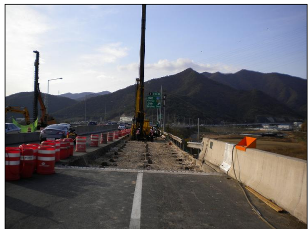
f) 연약지반 Twin-Jet 보강공법 시공전경
