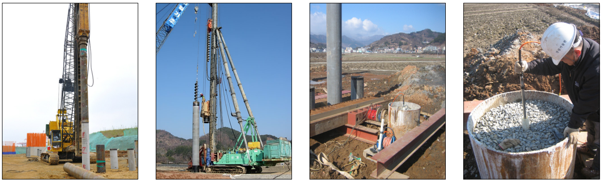
(a) 중구경 말뚝 시공 (b) 대구경 말뚝 시공 (c) 수평재하시험 전경 (d) 경사계 변위측정 그림 1. 중구경(직경 500mm) 및 대구경(직경 1,000mm) 복합말뚝 시공 및 재하시험 전경
