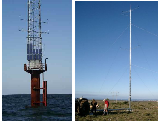
그림 5. 해상 및 육상 Met Mast
