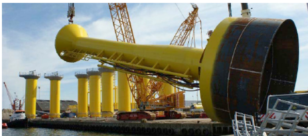
그림 10. Horns Rev II에 설치된 석션버켓기초
