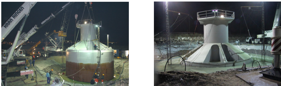
그림 7. Frederikshavn의 석션버켓기초의 현장실험 a) 설치중 b) 설치후
