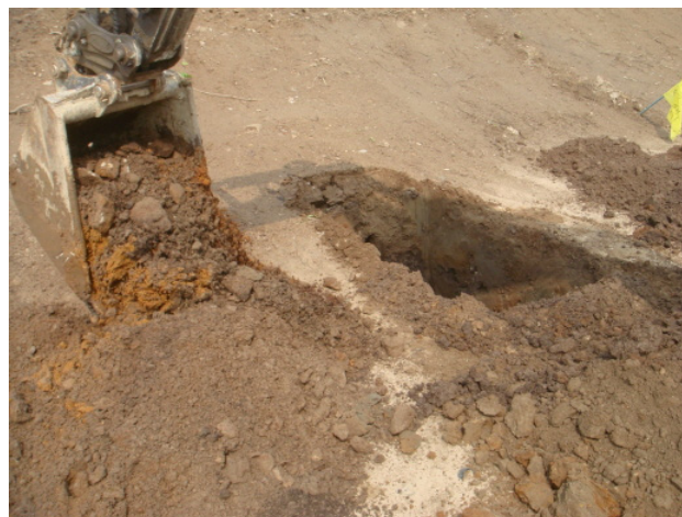
그림 12. MCPT 지반조사를 위한 상부 매립층 굴착
