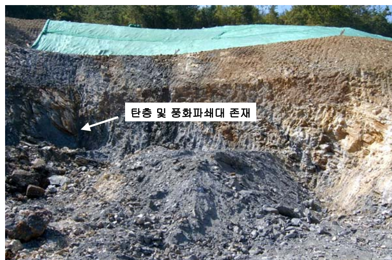
사진 1. 터널(상행선)갱구부 지질사진(탄층과 풍화파쇄대 혼재 상태임)
