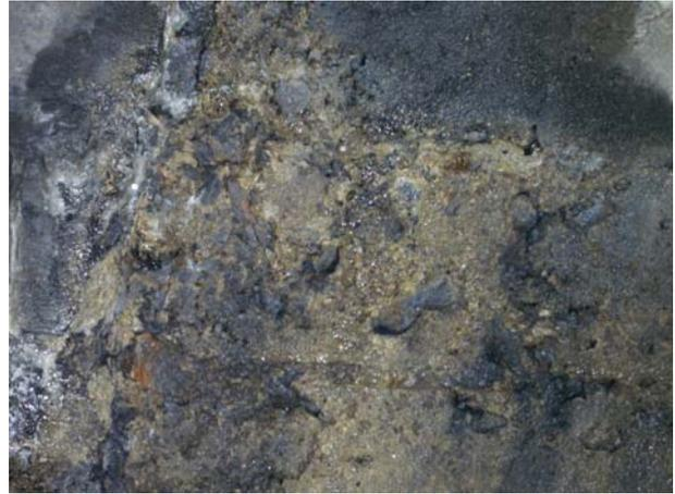
그림 3. 콘크리트 탈락, 골재노출
