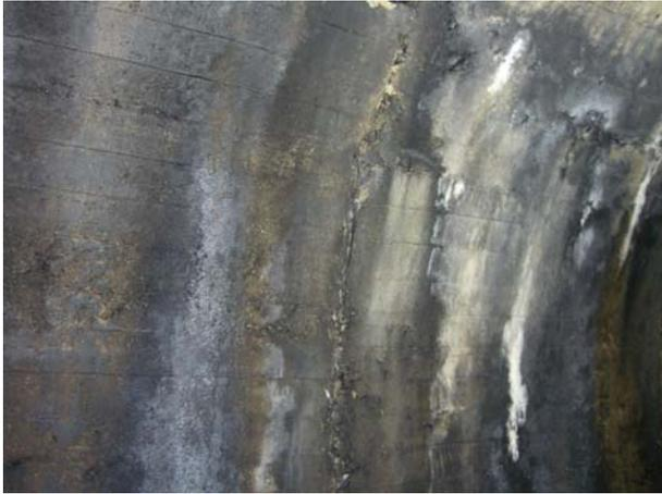
그림 2. Joint 부분 균열누수 백태
