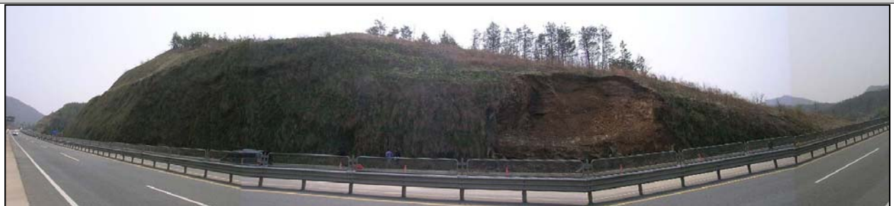
<사진 3.2.4> 사례 연구 절토사면 전경
