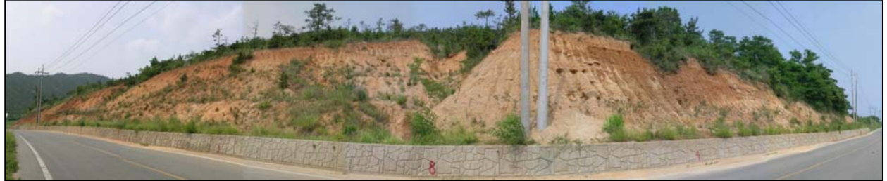
<사진 3.2.1> 사례 연구 절토사면 전경
