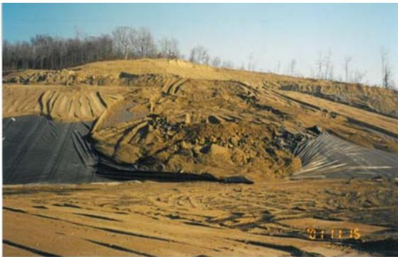
그림 1. 파괴된 매립장 사면 모습
