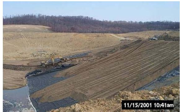
그림 2. 모래 배수재 시공 중인 사면 모습
