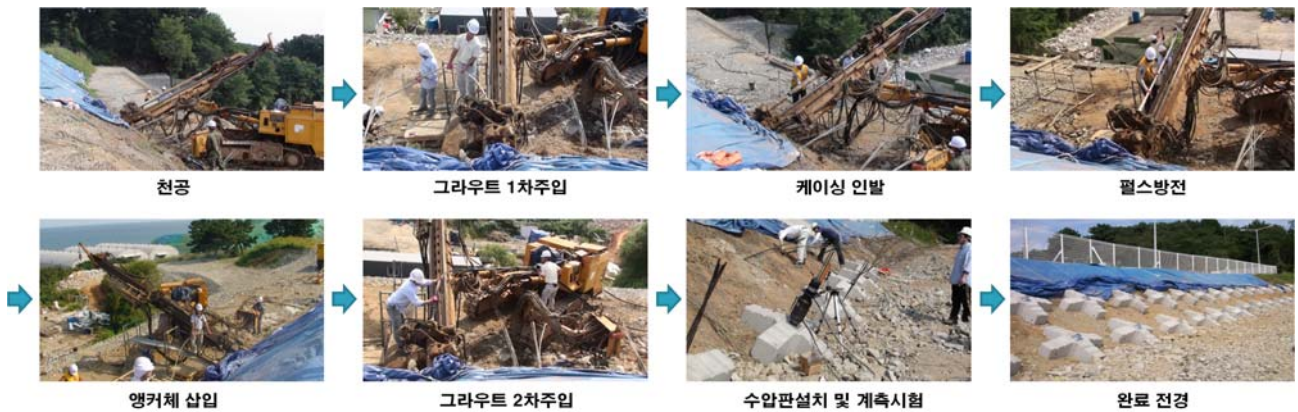
그림 11. 펄스앵커 시공순서
