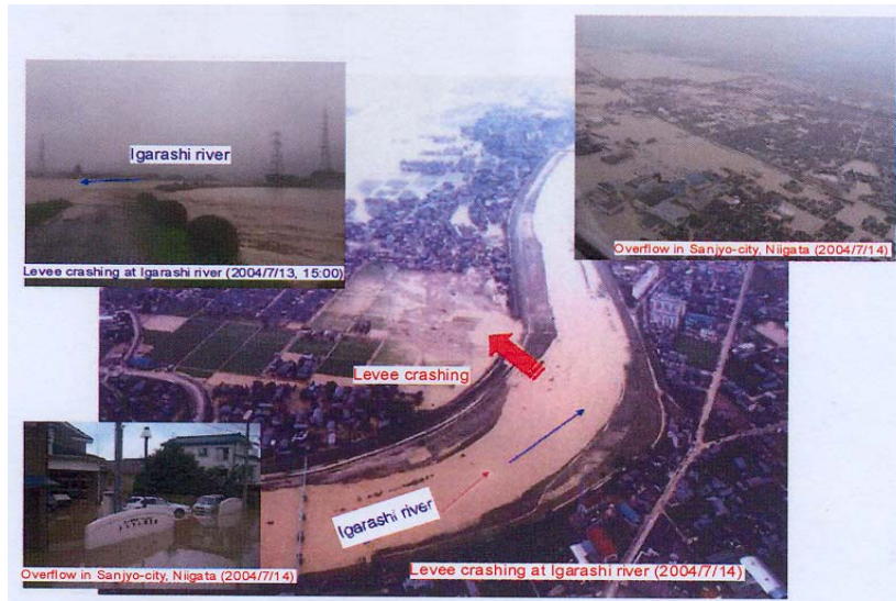
그림 2. 2004년 집중호우로 인한 Igarashi강의 제방붕괴 사고
