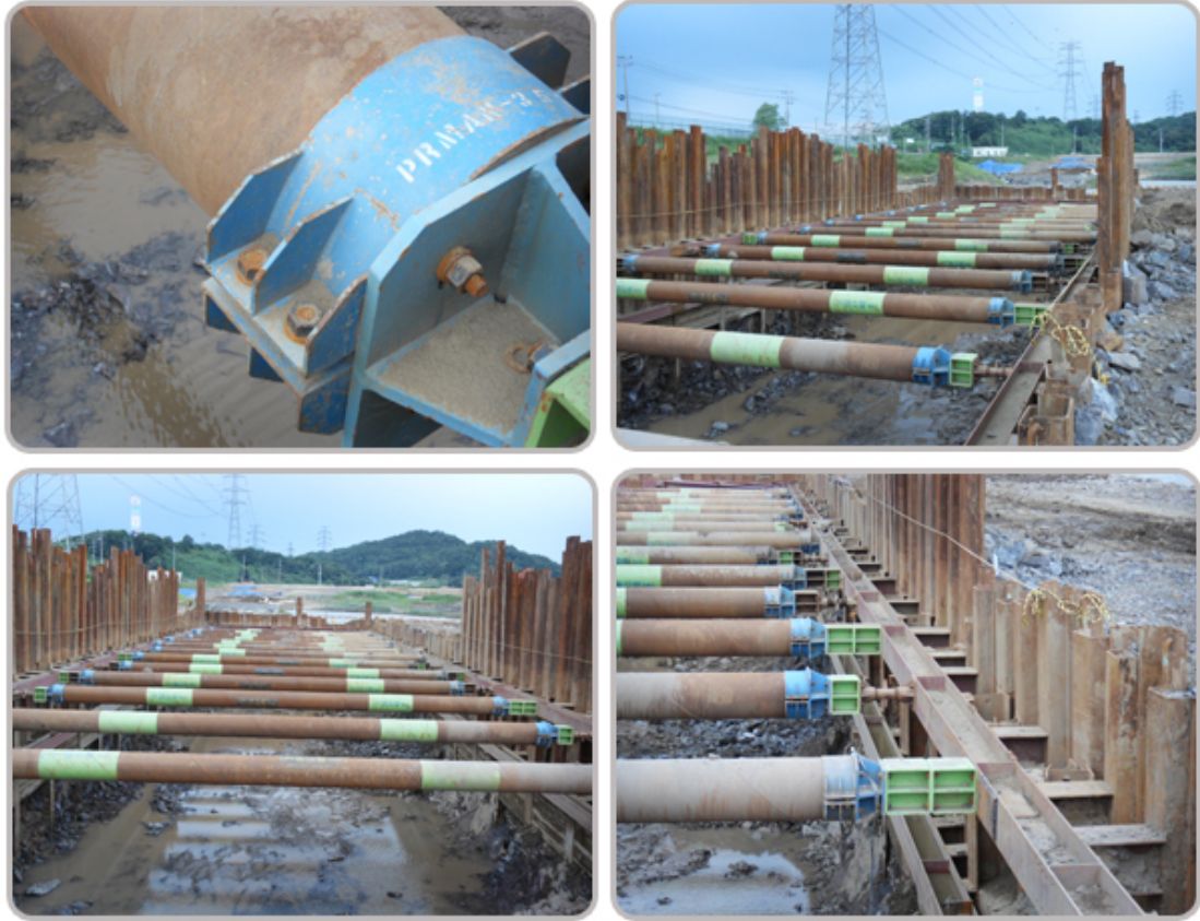
그림 1. 강관 버팀보 적용 굴착현장 예시 1 [(주)엠스틸인터내셔널 홈페이지]
