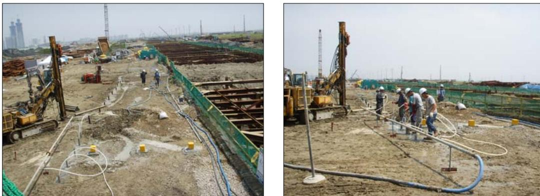
그림 4. 압력해소공 설치 및 지하수, 이토의 배토작업
