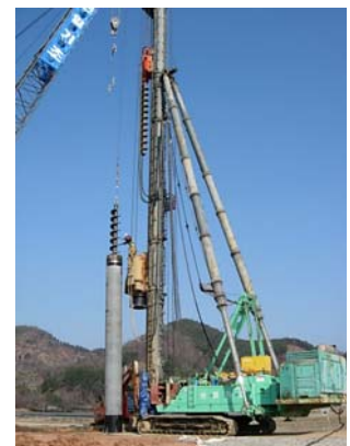
그림1. 중굴공법 시공전경
