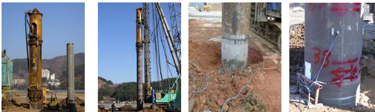
(a) 160kN급 유압 해머 (b) 대구경 말뚝 항타시공 (c)대구경 복합말뚝 동재하 (d) 대구경 PHC말뚝 동재하 그림 4. 대구경 PHC말뚝 및 대구경 복합말뚝 동재하시험 전경
