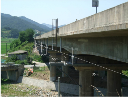
그림 1. 대상교량 및 상시진동시험 가속도계 설치 위치
