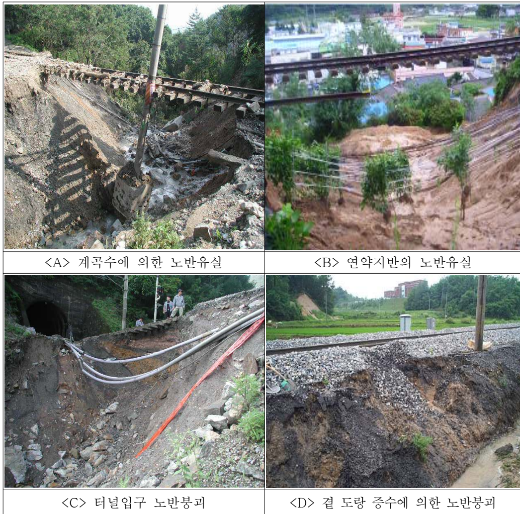
[그림 2.1] 호우로 인한 철도노반 유실
