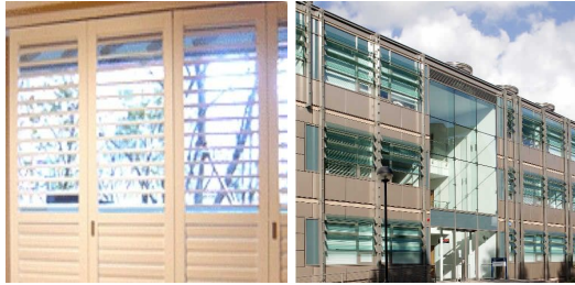
그림 1. 루버 시공사례(목재 및 유리)
