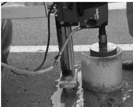
(a) 코어 채취 전경
