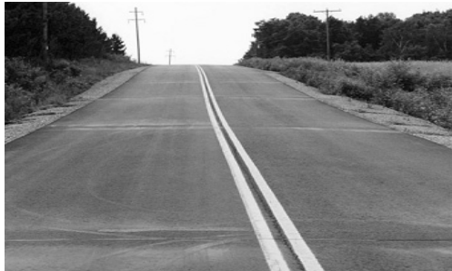
(a) Sawing & Sealing 포장 적용 도로
