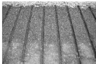
(d) 처리 후-노면 이물질제거
