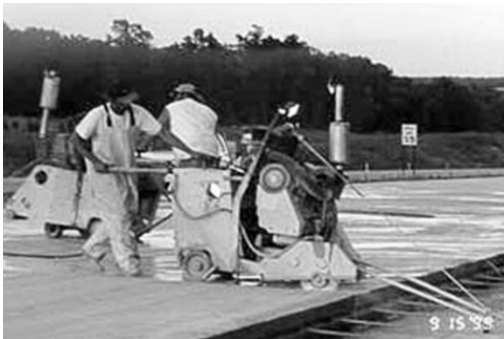
그림 1. 습식줄눈절삭(좌) 및 조기건식줄눈절삭(우)
