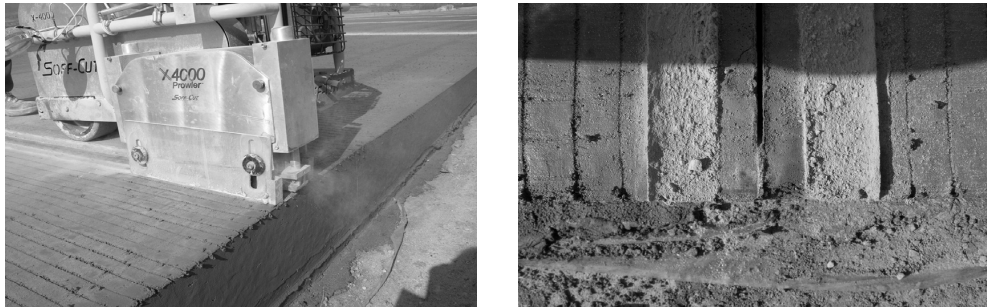
그림 5. 조기건식줄눈절삭 및 절삭한 줄눈 모습
