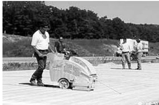
그림 1. 습식줄눈절삭(좌) 및 조기건식줄눈절삭(우)
