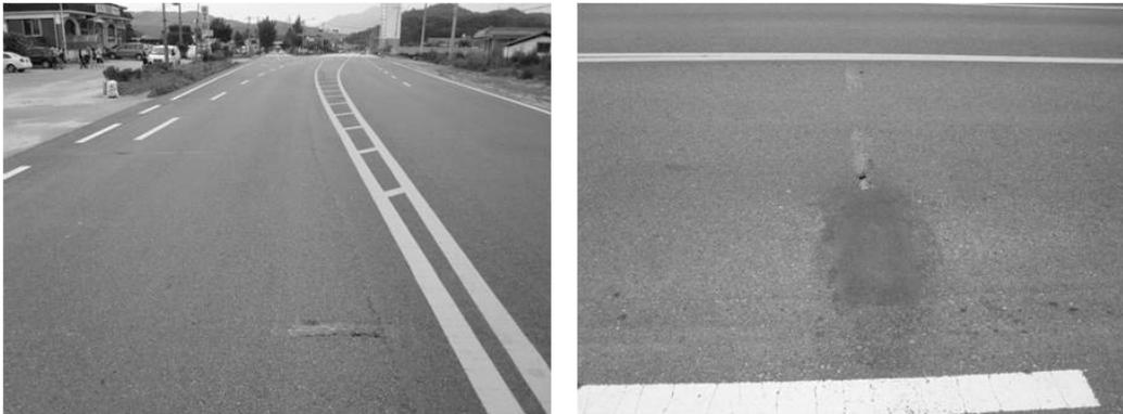
그림 5. 2차 추적조사(비교구간 A 균열발생 모습)
