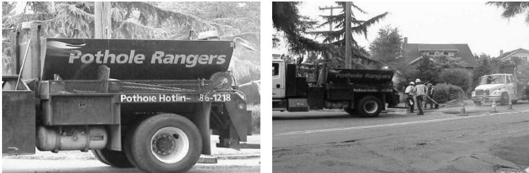
그림 3. 포트홀 보수차량(재료 박스 탑재)와 보수 현장(WSDOT Pavement Guide)
