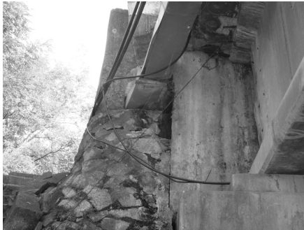
그림 7. 금강 4교 날개벽위치에서의 공동 발생
