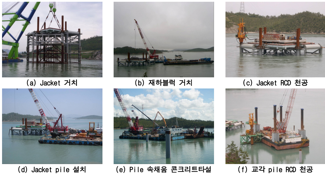
Fig. 8 울돌목 시험조류발전소 기초 시공 전경
