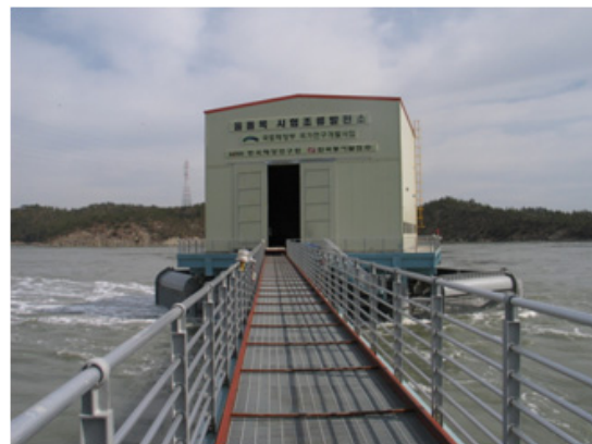
Fig. 1 울돌목 시험조류발전소 전경
