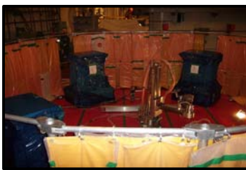
Fig 4. 납차폐체 설치후 모습
