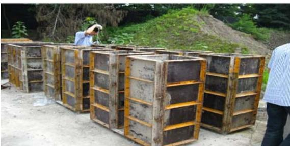
그림 3. 고강도 콘크리트 Mock-up기둥 시험체 제작 장면
