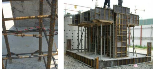
(c) 게이지 설치 (d) 거푸집 조립
