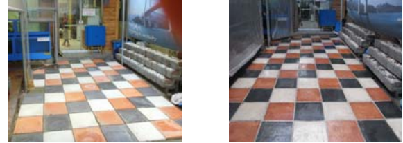
b) 투명 에폭시도료 도포 전후 사진 1. 컬러 콘크리트 패널시공
