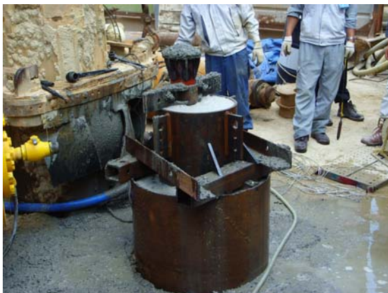
Fig. 10 Pouring Concrete
