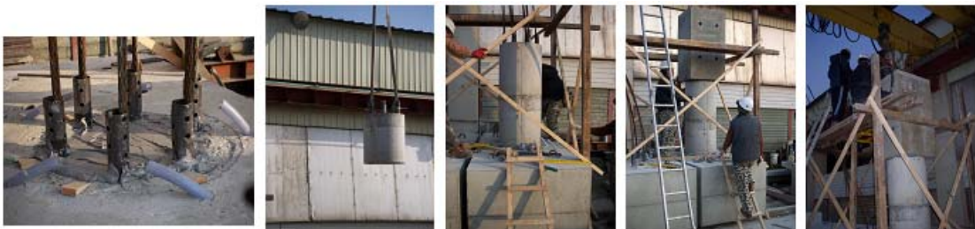
그림 2 프리캐스트 기초부를 갖는 조립식 PSC 교각 실험체
