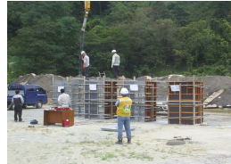
사진1. 콘크리트 타설 전경
