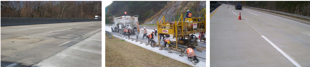
그림 1. VES-LMC를 이용한 접착식 콘크리트 덧씌우기 공법
