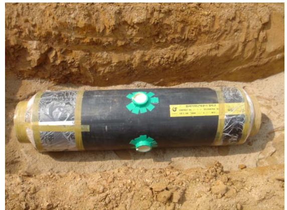
(c) 하부 되메움재 포설 및 열배관 설치 모습
