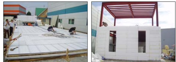
Fig.2 바닥층/벽체 단열시공 장면
