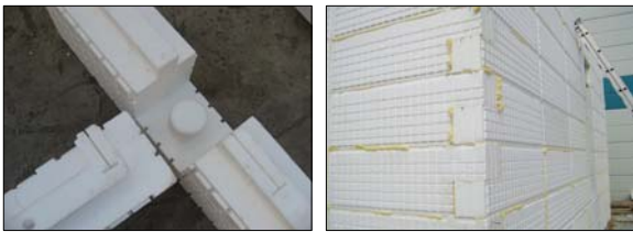
Fig.5 블럭시스템 T형 모서리 접합 상세
