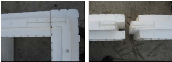
Fig.4 블럭시스템 모서리/벽체 접합 상세
