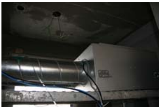
Fig. 7 실험에 사용된 환기유니트 전경
