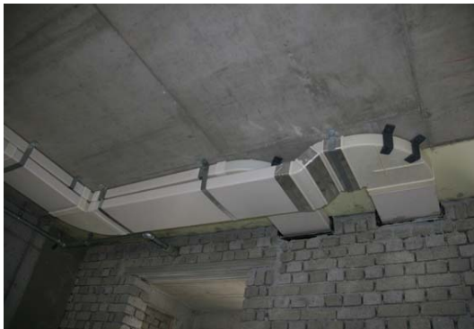
Fig. 6 환기덕트 설치 전경
