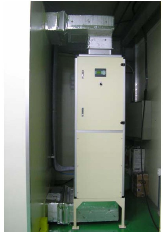
Fig.11 항온항습 실험실 B실용 항온항습기
