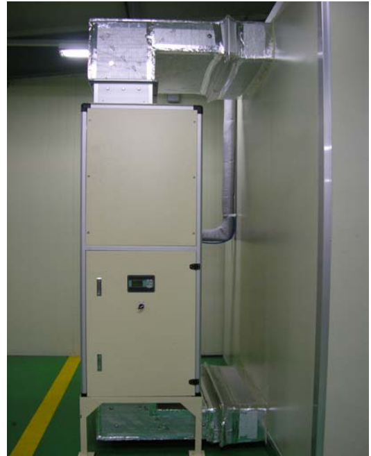
Fig.10 항온항습 실험실 A실용 항온항습기 사진
