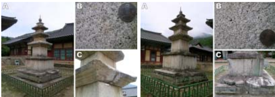
Fig. 1. 동삼층석탑(A:탑, B:표면, C:훼손현황). Fig. 2. 서삼층석탑(A:탑, B:표면, C:훼손현황).
