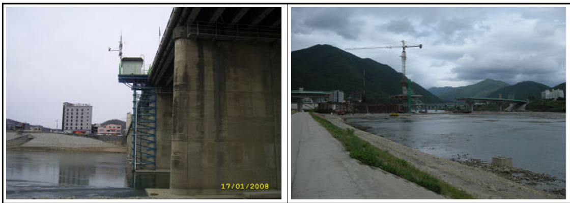
그림 1. 영월 수위관측소 현장 사진 (좌:수위관측소 전경, 우:동강대교 재설치 공사)
