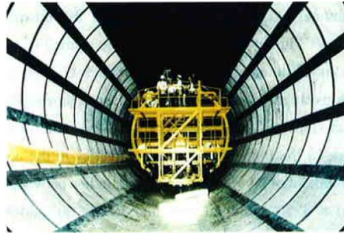
그림 4.5 복공판 설치 후 기밀시트 시공 모습(合田佳弘, 2002)
