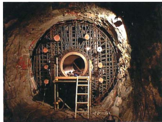
그림 3.4 압축공기 저장공동 플러그 철근배열(電力中央研究所, 2003)
