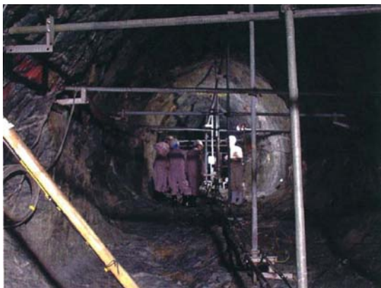
그림 3.3 압축공기 저장공동 내부(電力中央研究所, 2003)
