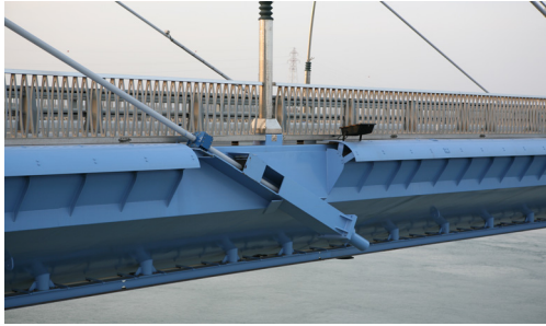
그림 3. 불연속적인 Vane의 설치
