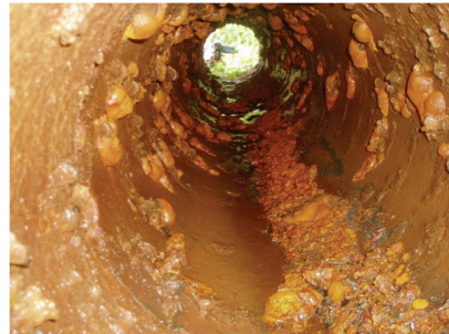
그림 2. 상수도관 내부 모습.
