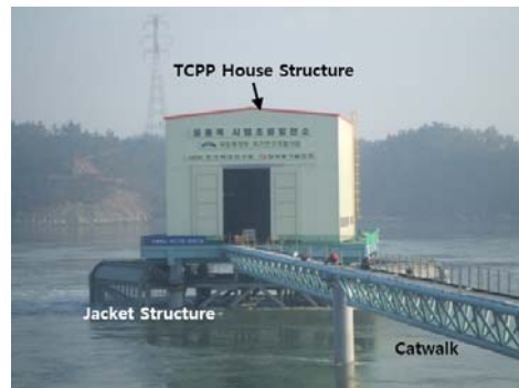
그림 1. 시험조류발전소 완공 후 사진
