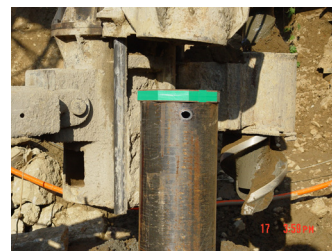
그림 2.2 말뚝쿠션 설치 위치
