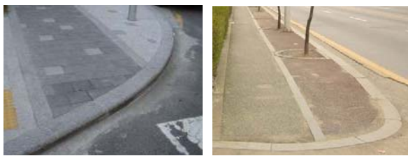
그림 1 인도에 설치된 자전거도로에 오르기 위한 턱(raised spot)의 예시
