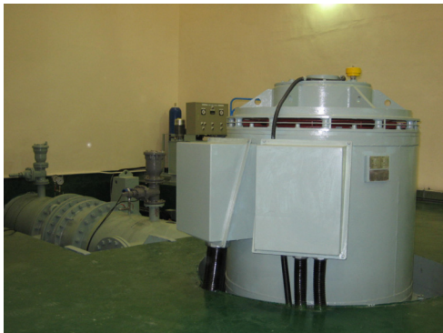
[그림 6] 설치완료된 프란시스수차발전기
