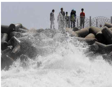
[그림 1] 방파제 안전시설 부족
