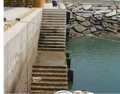
[그림 8] 난간 및 차량막 안전시설 부족(학암포)
